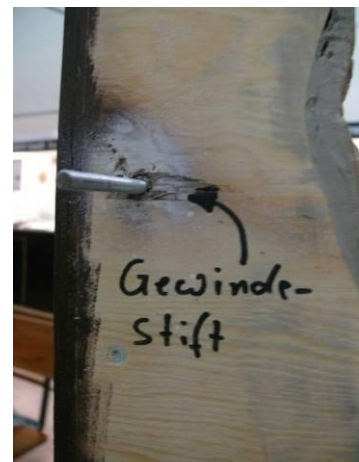
Bild 2: Gewindestifte in eingelassene Gewinde eindrehen.
