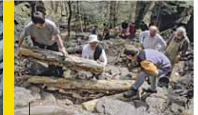
Arbeitseinsatz AKN Battert
